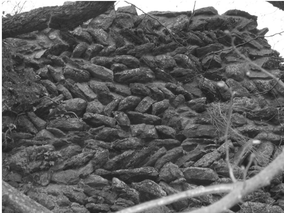
Abbildung 2: Mauerwerk in Fischgrätentechnik auf dem Kobel, Ende 12. Jahrhundert
