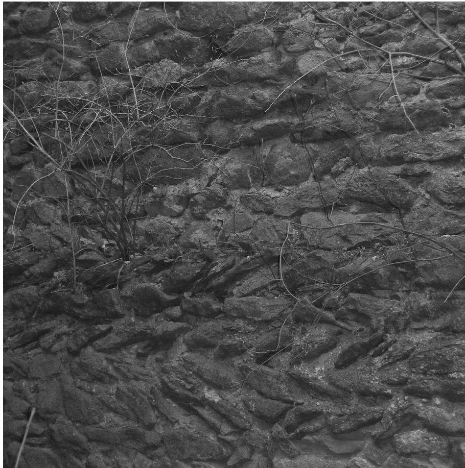
Abbildung 11: Der 1521 erneuerte Torbau, im unteren Teil kann man noch deutlich altes Fischgrätenmauerwerk erkennen.
